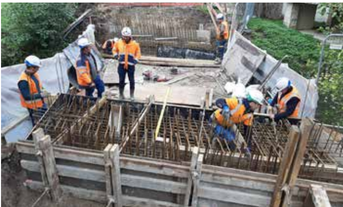
Travaux en cours
