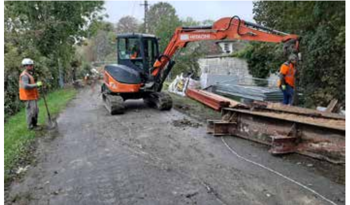
Travaux en cours
