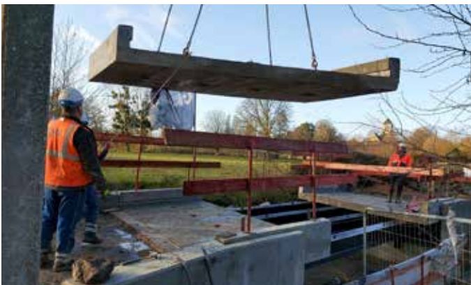
Travaux en cours
