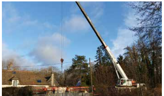
Travaux en cours
