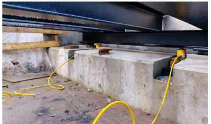
Travaux en cours
