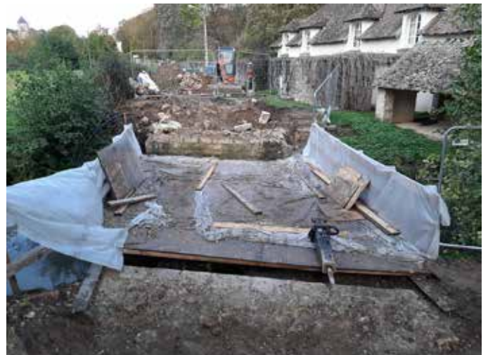
Travaux en cours
