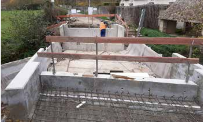
Travaux en cours
