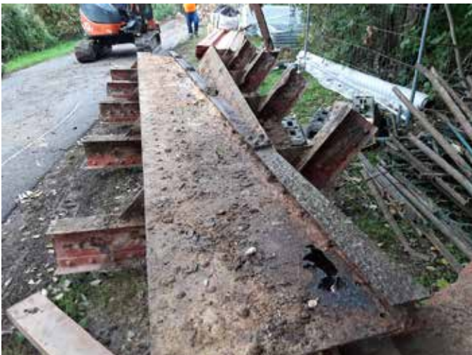
Travaux en cours
