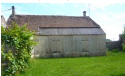
Logement de fonction - AVANT
