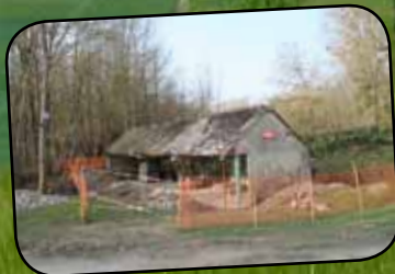
p. 9 La réfection du lavoir de Bichereau
