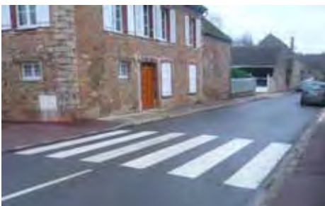
Remise en peinture de la signalisation horizontale et création de passages piétons
