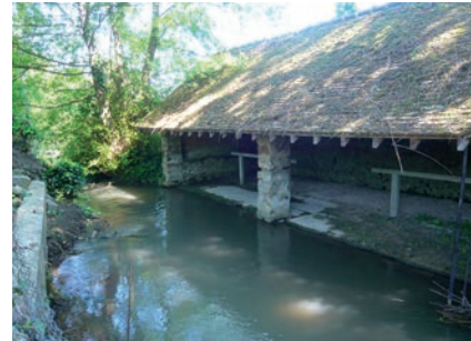
▲ Le lavoir de Chantemerle, rue du 19 mars 1962, à Thoury
